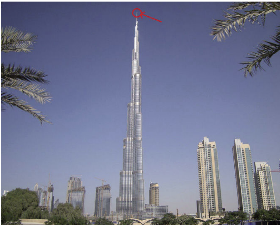
Fotografia 3. Najwyższy budynek z zainstalowanym w jego iglicy urządzeniem pomiarowym zbudowanym w oparciu o moduł LabJack
